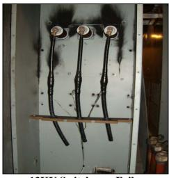
**13KV Switchgear Failure**
